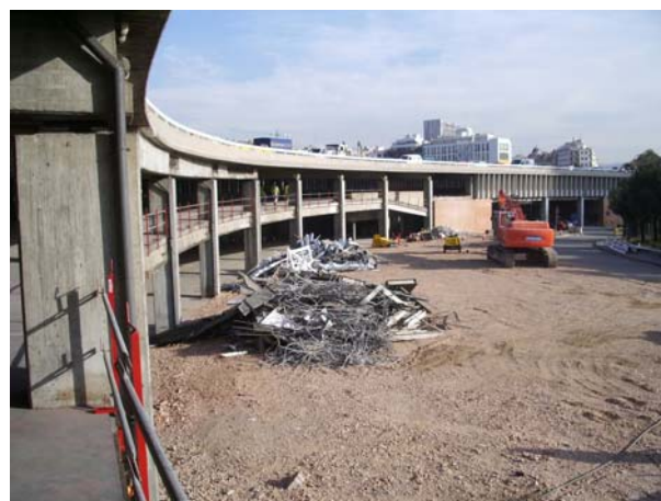
Deconstrucció de rampes, talussos interiors, forjat intermig dels aparcaments i tancaments de façanes de la Plaça de les Glòries (870-2008)
