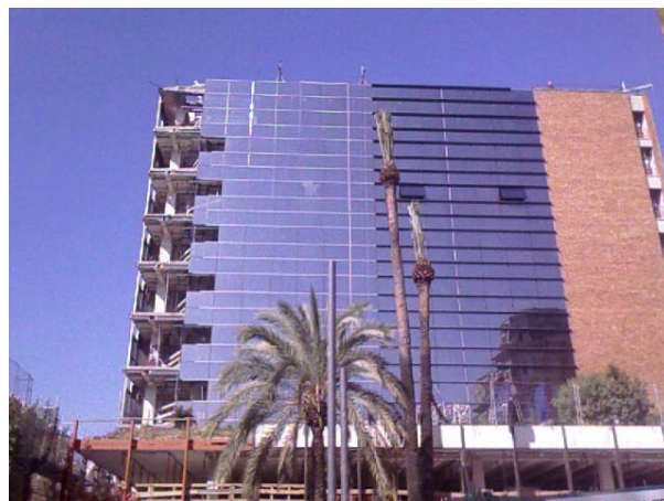
Reforma Instal·lacions i espais interiors. Seu del Departament d'Interior al C/ Diputació (442-2007)
