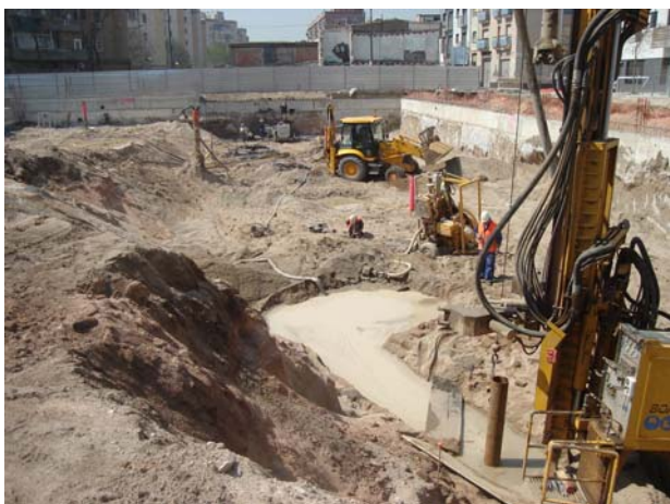
Edifici de 141 habitatges, locals comercials i aparcaments al Passeig Calvell (437-2006)
