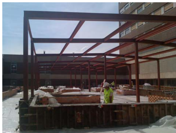
Reforma del Servei d'Urgències i Rehabilitació de l'Hospital Germans Trias i Pujol, Badalona (682-2008)
