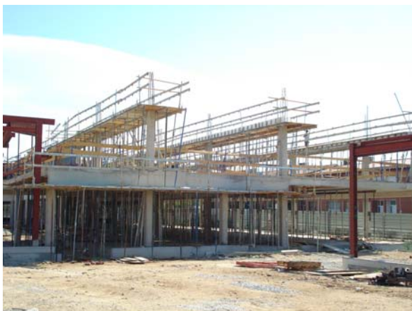
Nova construcció del CEIP l'Amistat de Figueres (378-2006)
