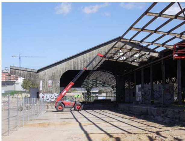
Deconstrucció de l'estació de mercaderies de la Sagrera, a Barcelona (590-2007)
