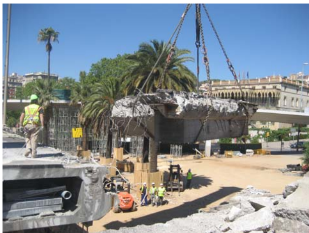
Enderroc dels Viaductes de la boca Sud del Túnel de La Rovira a la Ronda de Guinardó (938-2009)
